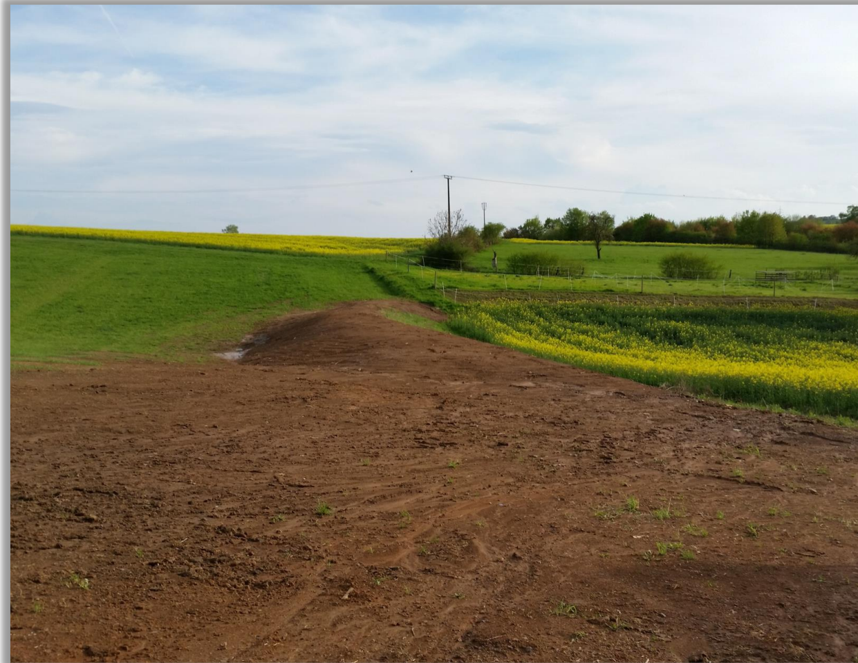
Sedimentfalle am Unterrand eines langen, geneigten Feldes (© Ortenberg)
