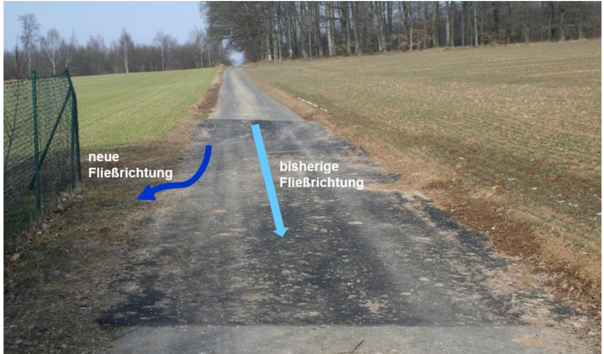
Anpassung der Wegneigung um abfließendes Wasser auf nebenliegende Flächen zu leiten © Altenstadt
