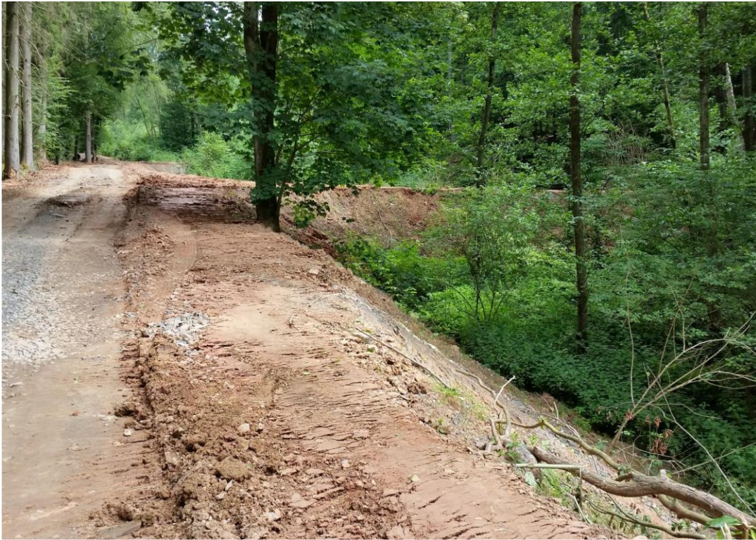
Erhöhung der hangseitigen Banketts an einem höhenparallelen Waldweg (© Ortenberg)
