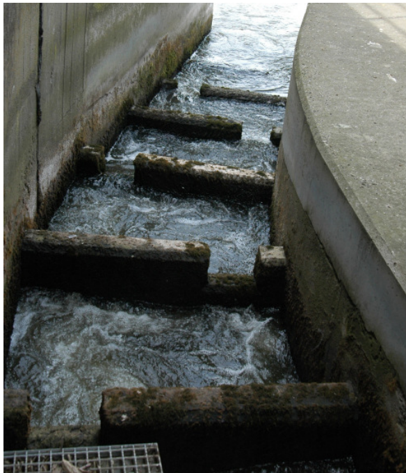
Abbildung 8: Fischpass Offenbach, Blick in Fließrichtung
