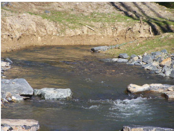
Bild 3: Umgehungsbach, Blick gegen die Fließrichtung
