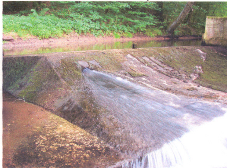
Bild: Durchströmung des Wehrkörpers (ID 13934) am 03.06.2009, Rohr DN200, OK: 25cm unter Wehrkrone
