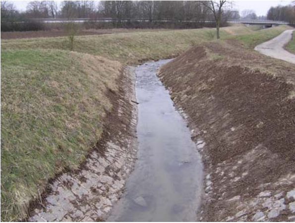
© Ulrich Androsch Zustand vorher: Sohle und Böschung gepflastert
