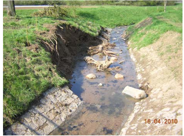
© Ulrich Androsch Zustand nachher: Aufbruch und Entnahme des Gewässer-verbaus links, Störelemente, Erosion.
